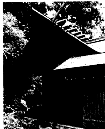
挿図-16 鹿島神社 本殿 左側面
