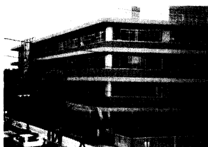
写真-2 北区区役所庁舎 (旧北区郵便局)
