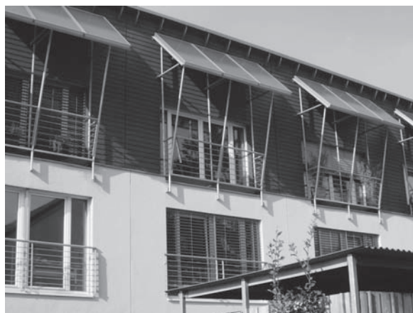
図6 太陽光パネルの庇
