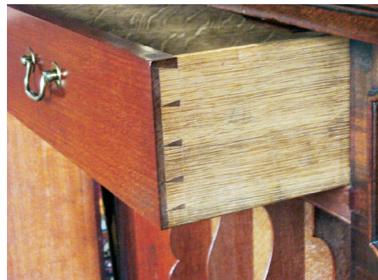
図 30 扉内部の引出前板と側板の包み蟻組接ぎ
