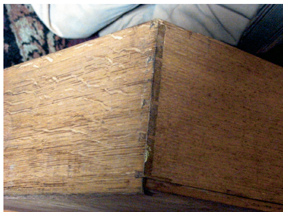
図 31 引出側板と向板の蟻組接ぎ
